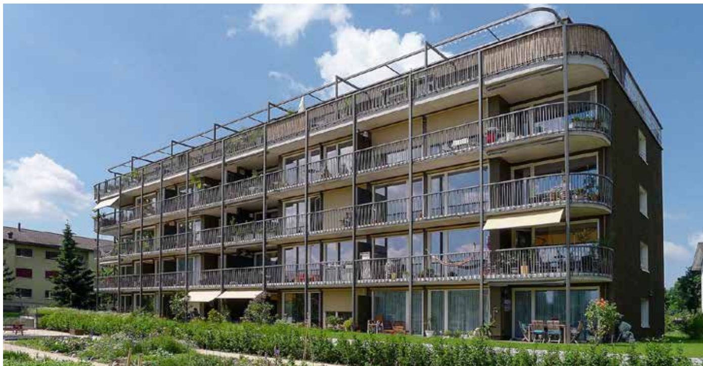
Der Neubau der Wohnbaugenossenschaft Hagnau in Birsfelden (BL) kam unter anderem dank Fördermitteln aus dem Fonds de Roulement zustande ( www.hagnauer-gaerten.ch ).
