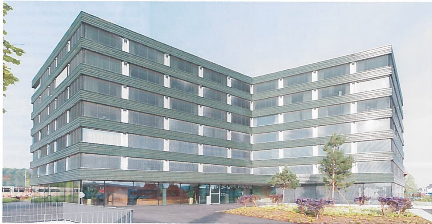
In Muttenz hat Implemia für das Alters- und Pflegeheim «Zum Park» einen Ersatzneubau realisiert. Die Eröffnung fand im Frühling 2016 statt.
